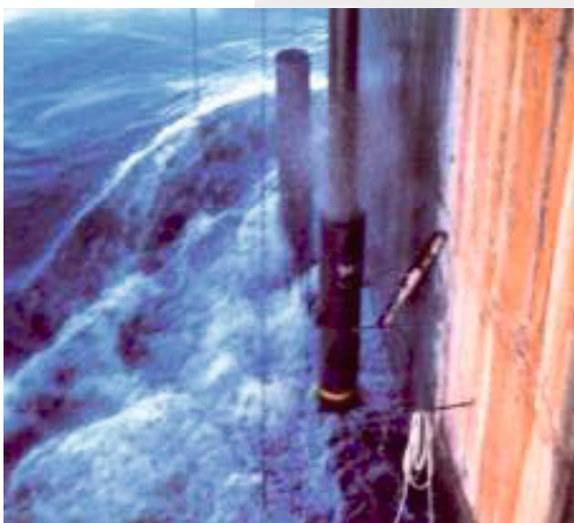
Perfuração das Estacas Raiz Ø 355mm em rocha internamente à camisas metálicas cravadas no tabuleiro da ponte.
