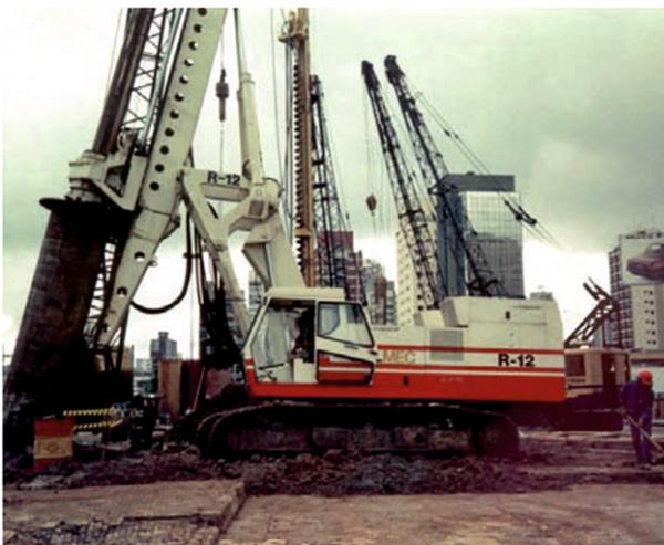
Perfuração e encamisamento das estacas inclinadas secantes.
