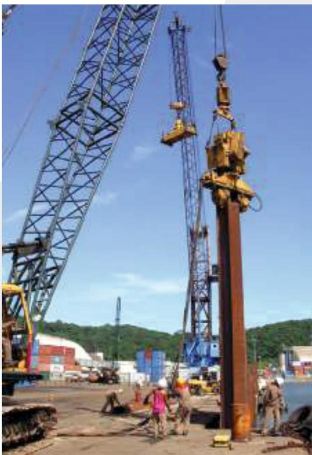
Cravação de Estaca Prancha - Vibrador Elétrico VTE Soilmec | Porto de São Francisco do Sul - SC.
