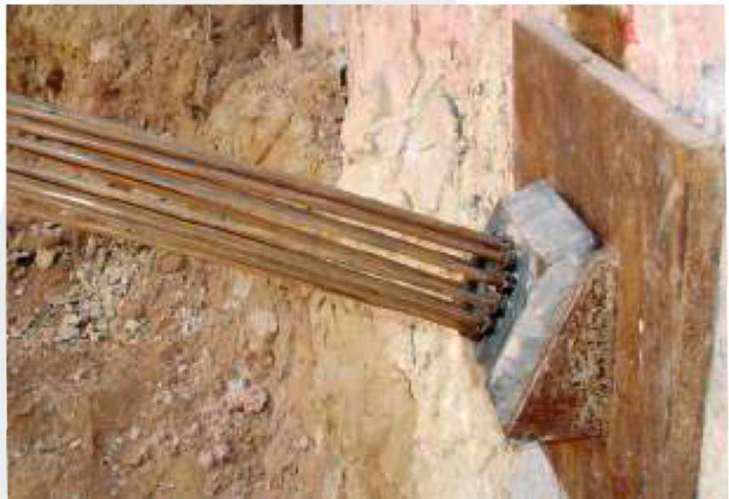
Detalhe Cabeça do Tirante, Placa de apoio, bloco de ancoragem e fios (cabeleira).
