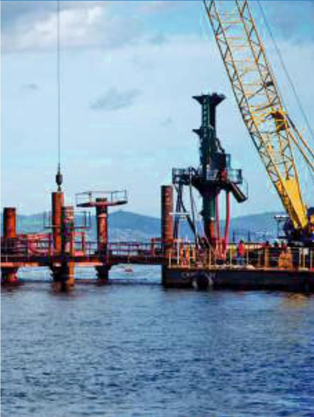
Execução de estaca escavada encamisada em solo e rocha.
