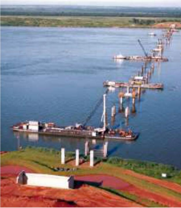
Execução de estacas escavadas com diâmetros 130, 140 e 190 cm embutidas em arenito e basalto.
