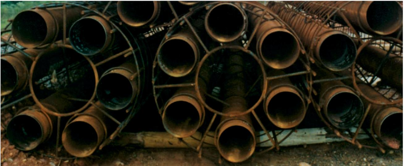
Armaduras das estacas escavadas com tubos guia para execução de estacas raiz de ancoragem em rocha.
