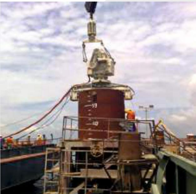
Cravação da camisa metálica com vibrador.
