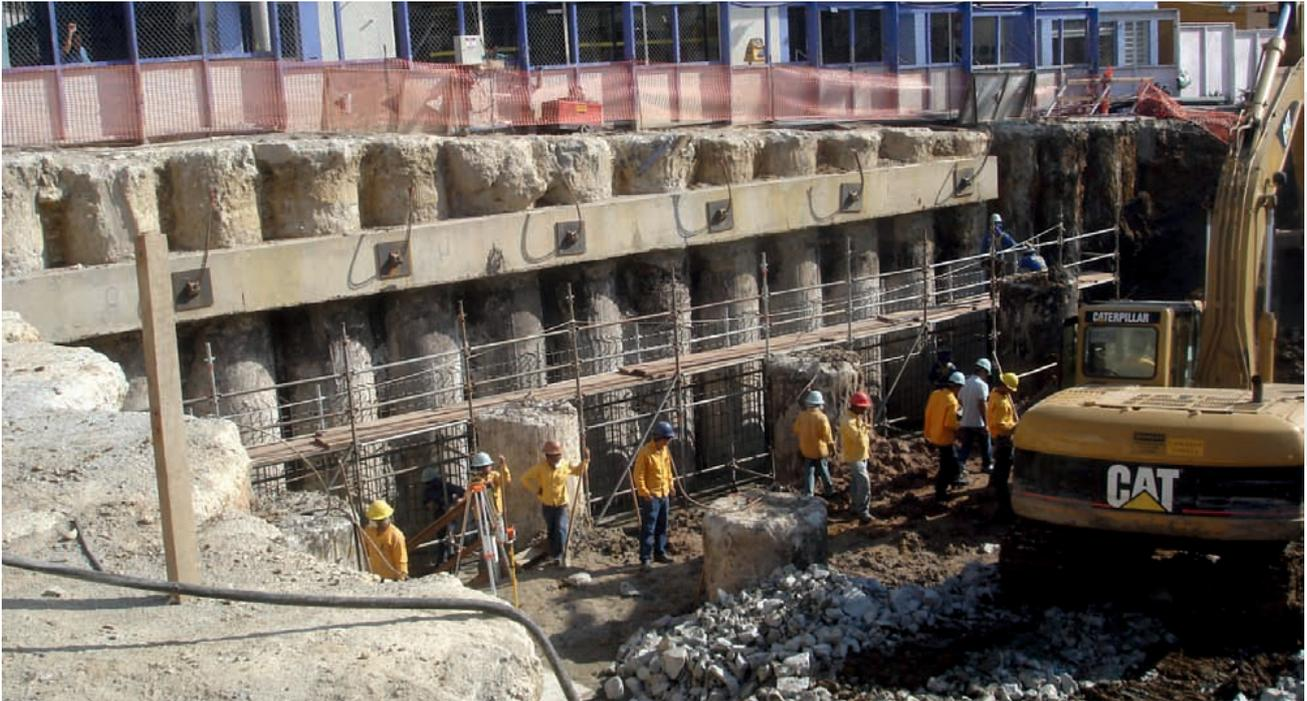
Contenção em Estacas Escavadas - Estação Sacomã - Metrô - SP
