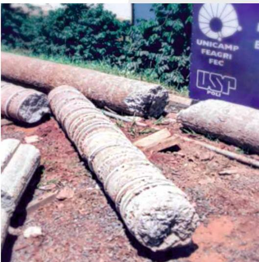
Detalhe do fuste e ponta da Estaca Ômega.
