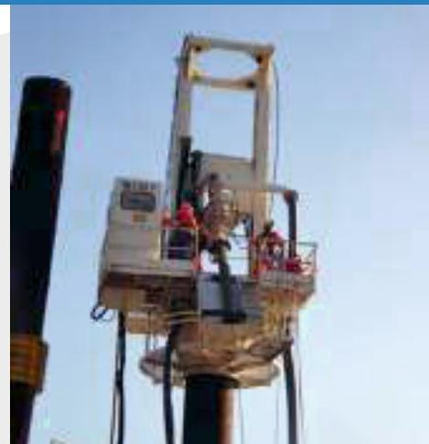
Cravação de estacas tubulares e estacas prancha metálica.
