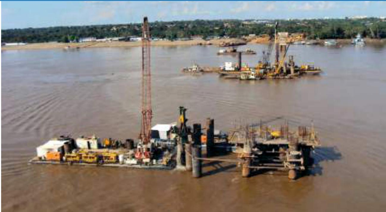
Execução de estacas escavadas Ø 200cm em solo e com embutimento em solo Ø 180cm.
