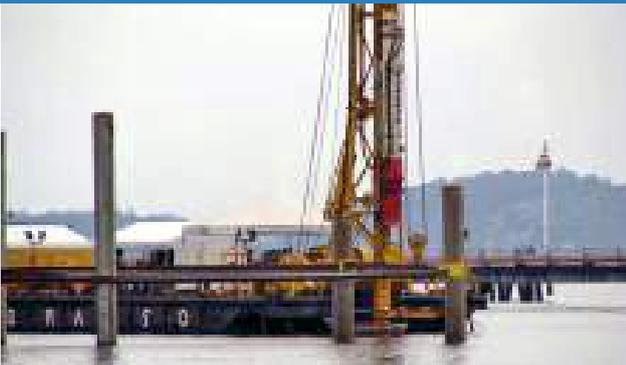
Cravação de estacas de concreto Ø 80cm vazadas.
