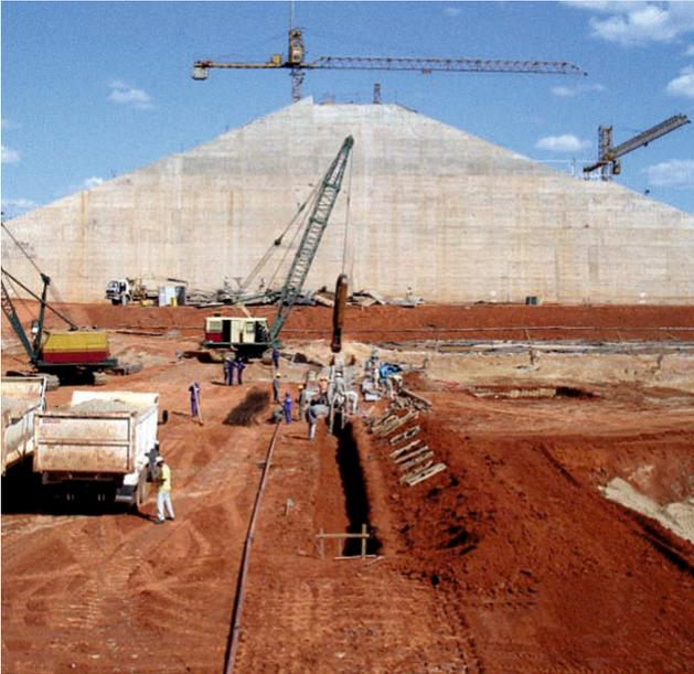
Cutoff em Parede Plástica | PCH Canoa Quebrada/MT.
