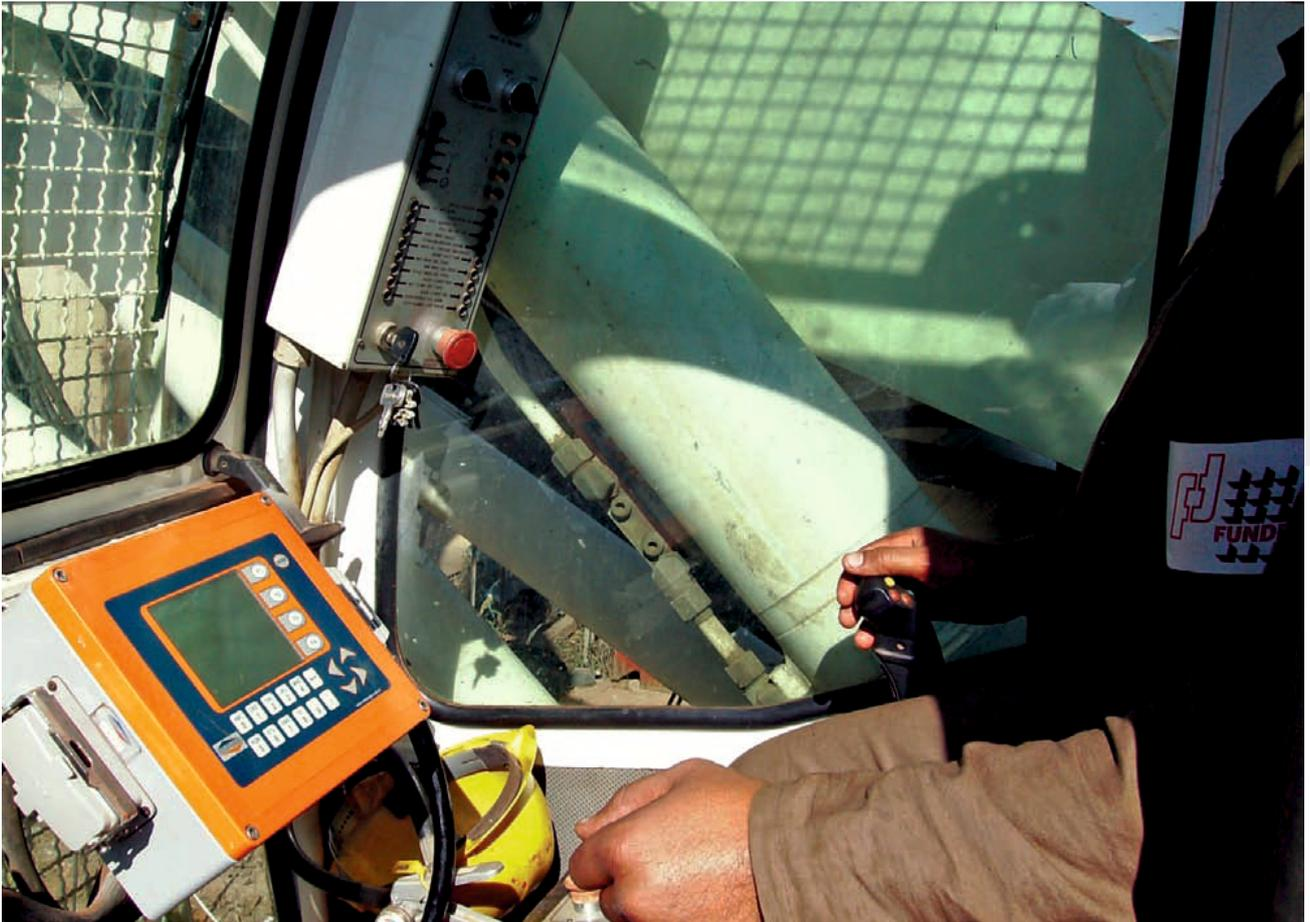
Computador de bordo para monitoração da execução da Estacas Hélice Contínua.
