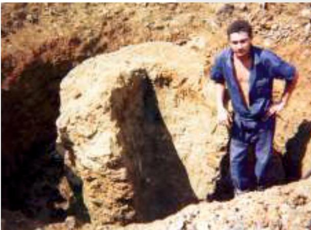
Detalhe da verificação do núcleo da coluna de Ø 120cm | Linha Verde - Sergipe/SE.
