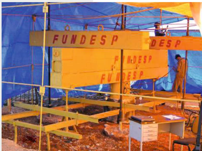
Conjunto de reação para prova de carga até 380tf.
