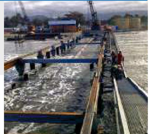
Cravação de estacas tubulares e estacas prancha metálica.
