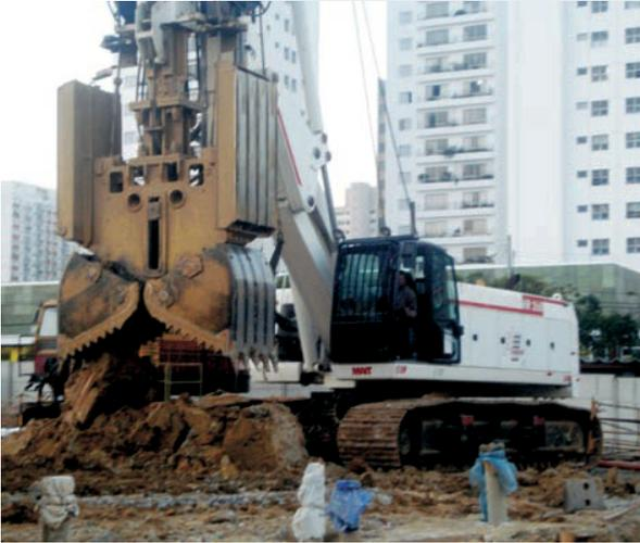
Parede Diafragma com Clam-Shell hidráulico.
