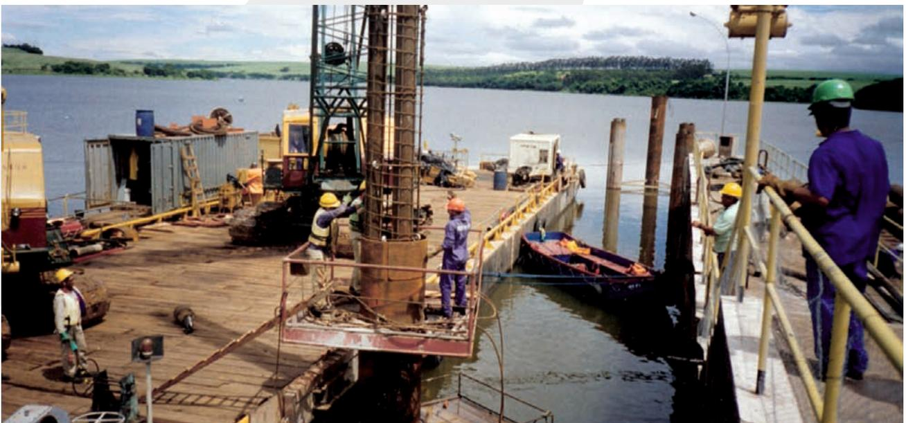
Estacas escavadas ancoradas em basalto em Estaca Raiz - Eclusa de Barra Bonita/SP
