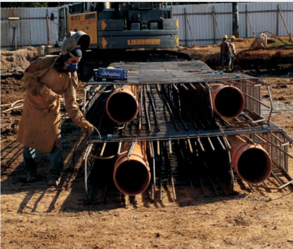
Armadura da Parede Diafragma com tubos guia para execução de estacas raiz.
