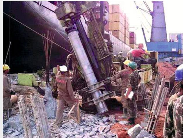
Execução de estacas raízes inclinadas.
