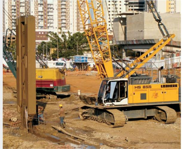
Parede Diafragma com Clam-Shell mecânico.
