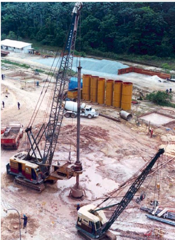
• Execução de Estacas Ø160cm com 50m de profundidade Alunorte - Barcarena/PA.
